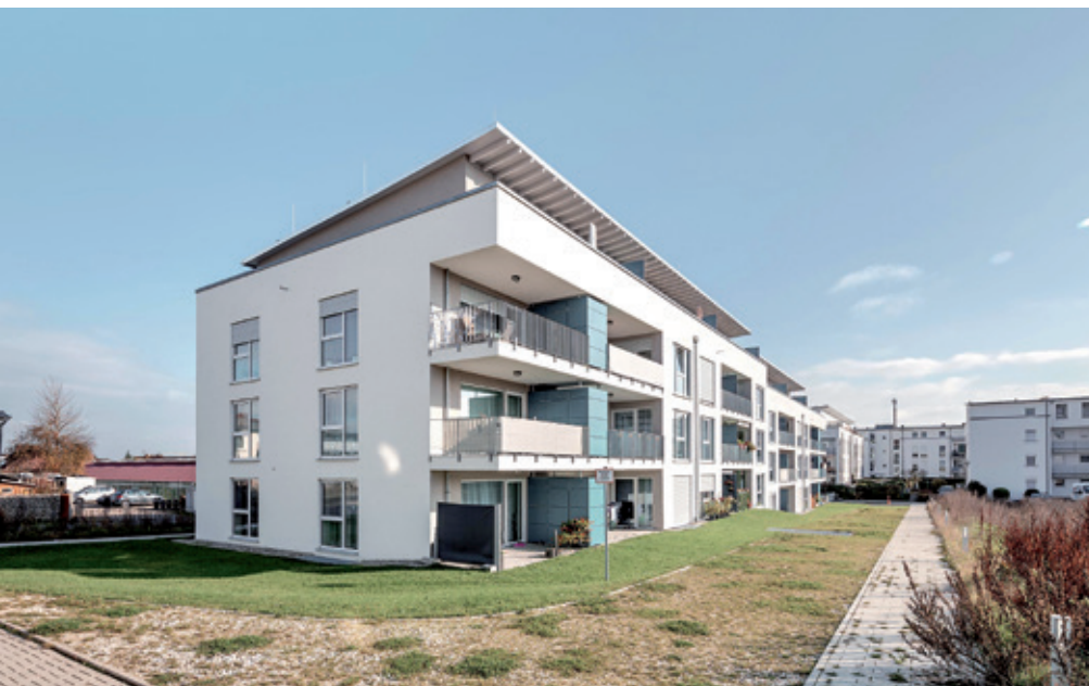
Auf dem Zeppelingelände in Ehingen sind im letzten Jahr weitere 30 Mietwohnungen – davon 16 geförderte Mietwohnungen – der GWO fertiggestellt und bezogen worden. Foto: MÖRK
